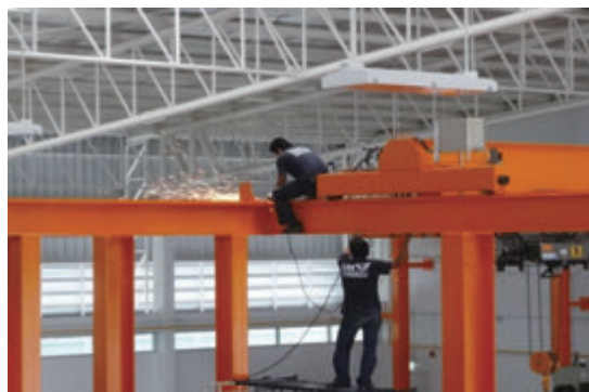
ヘルメット・安全帯・手袋の未着用、防火養生の配慮無し、等危険な作業を行う業者は、納期もルーズです。
