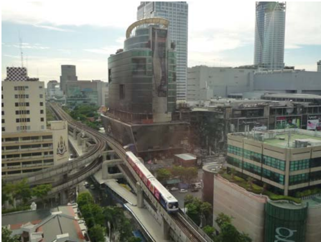
JCC 事務局から見えるデモで崩壊した商業施設
