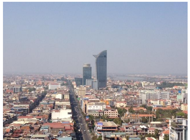
プノンペンの市内中心部には高層ビルも建ち始めている
