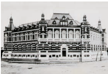
東京商業会議所ビル (現東京商工会議所)
