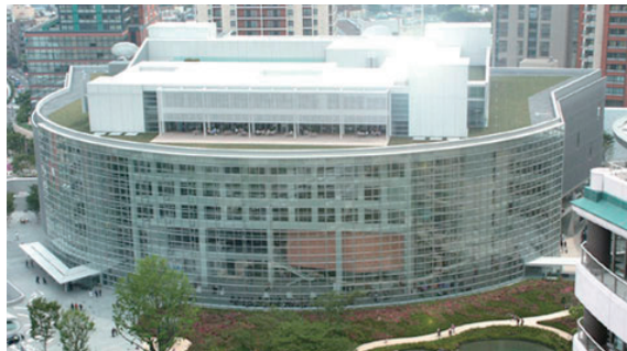
東京スカイツリーの第一・第二展望台や新丸ビル、さいたまスーパーアリーナなど、日本を代表する大型施設の建設にも多数参加している（写真はテレビ朝日放送センター）
