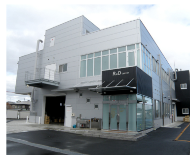
新設されたばかりの新技術棟。内部には分析、試験室や技術研究所がある
