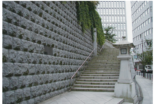
赤坂・日枝神社の壁石・階段の改修工事
