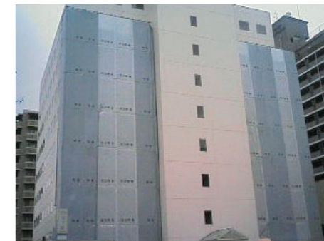
遮音性・耐久性・防炎性を備えた「防音シート」。建築工事現場、解体工事現場、工場等で広く使われている
