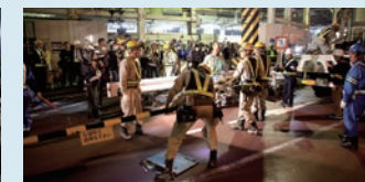
切替工事当日の様子（空港線） 写真提供：京浜急行電鉄㈱
