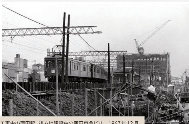
工事中の蒲田駅、後方は建設中の蒲田東急ビル 1967年12月 写真提供：東急(株)
