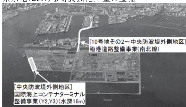
東京港における耐震強化岸壁の整備
