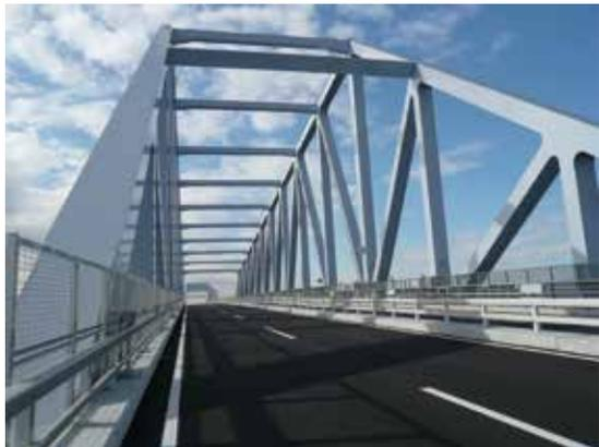
主橋梁は鋼3径間連続トラス・ボックス複合構造により、大型船舶が航行できる桁下の高さ、上空を飛ぶ飛行機の空域制限をクリア。夕暮れ時には特殊な構造のシルエットがいつそう際立ちます。
