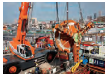
ハーモニカシールドの投入・引き上げ工事
