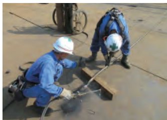
据え付け工事では溶接作業も行うため、新入社員は訓練を行う。
