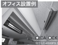
吸着力200kgのマグネット電気錠は管理用オートロックシステムです。停電時はオプションのバッテリー装置により5時間の施錠を保持できます。
