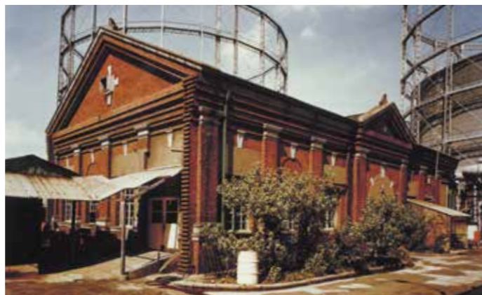
東京瓦斯千住工場 取り壊し直前の計量器室(GAS MUSEUM がす資料館蔵)
