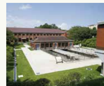
旧三河島汚水処分場唧筒場施設(国重文)
