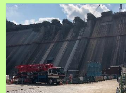
2019年度完成予定のハツ場ダム(群馬県)は、洪水調節・流水の正常な機能の維持、水道及び工業用水の新たな確保並びに発電を目的とする多目的ダムであり、大きなストック効果が期待される(左:ダム上流、右:ダム下流の建設現場。2018年10月)
