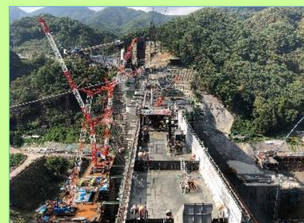
2019年度完成予定のハツ場ダム(群馬県)は、洪水調節・流水の正常な機能の維持、水道及び工業用水の新たな確保並びに発電を目的とする多目的ダムであり、大きなストック効果が期待される(左:ダム上流、右:ダム下流の建設現場。2018年10月)
