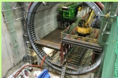
外環（関越～東名）東名JCT（本線シールドトンネル）（国交省関東地方整備局資料より）
