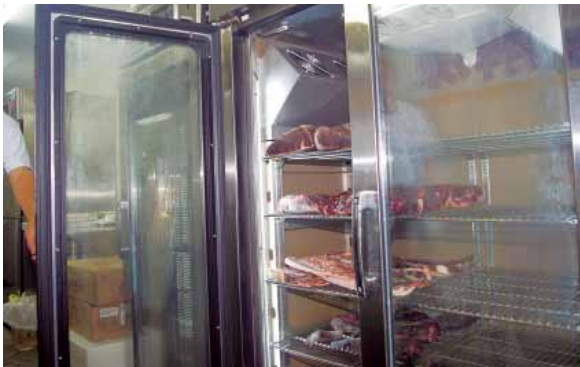
世界ではじめてと自負する、解凍・熟成庫。肉の旨味のもととなるドリップ(肉汁)を逃がさない解凍を行い、冷凍肉の熟成を可能とした。
