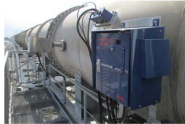
工場に設置されている白濁排ガス用ダスト濃度計
