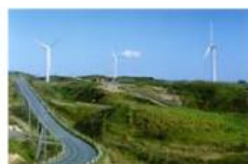
稚内風力発電所
