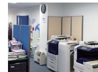
騒音が気になる複合機の周囲に、「吸音ローパーティション」を施工。印刷作動音を抑え、仕事に集中できる環境が実現
