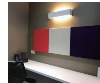
「吸音壁貼タイプ」を電話ブースに施工。音の反響が抑えられ、電話で話しやすい空間に。またカラフルなパネルが明るい雰囲気演出
