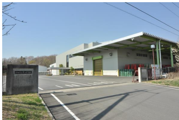
01年に竣工したリサイクルプラント
