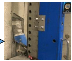
消音・消塵を可能にした新工法 65dB（普通の会話・チャイムと同程度）
