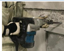
大きな騒音と粉塵が舞う従来工法 100dB（電車が通るガード下と同程度）
