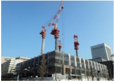
▲＜写真27＞ 建築現場全景写真（3/29）
