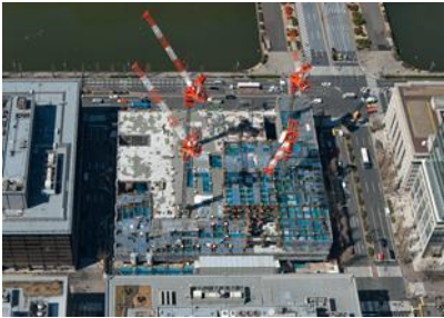
▲＜写真26＞ 建築現場航空写真（3/16）
