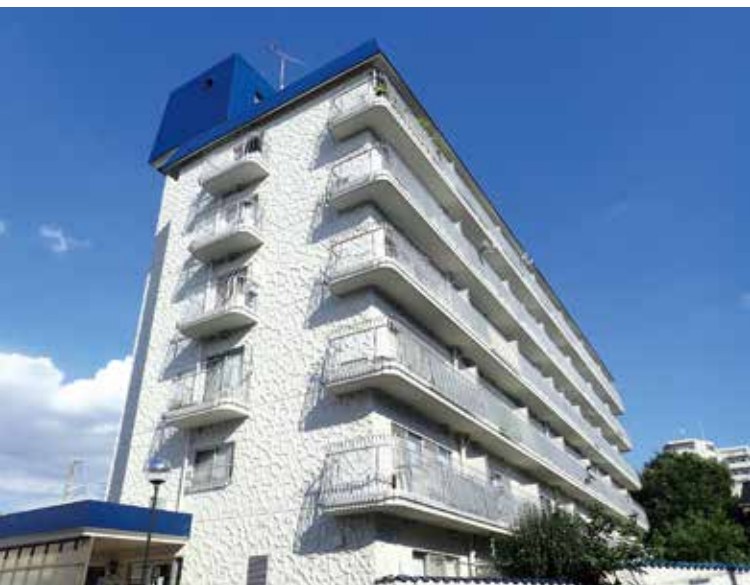
創業して間もなく行ったマンション大規模修繕工事
