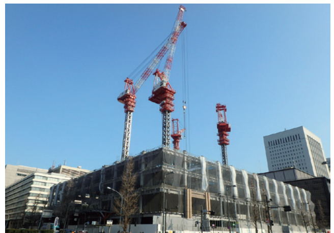
2017年3月29日時点の建築現場全景写真(日比谷通りより)
